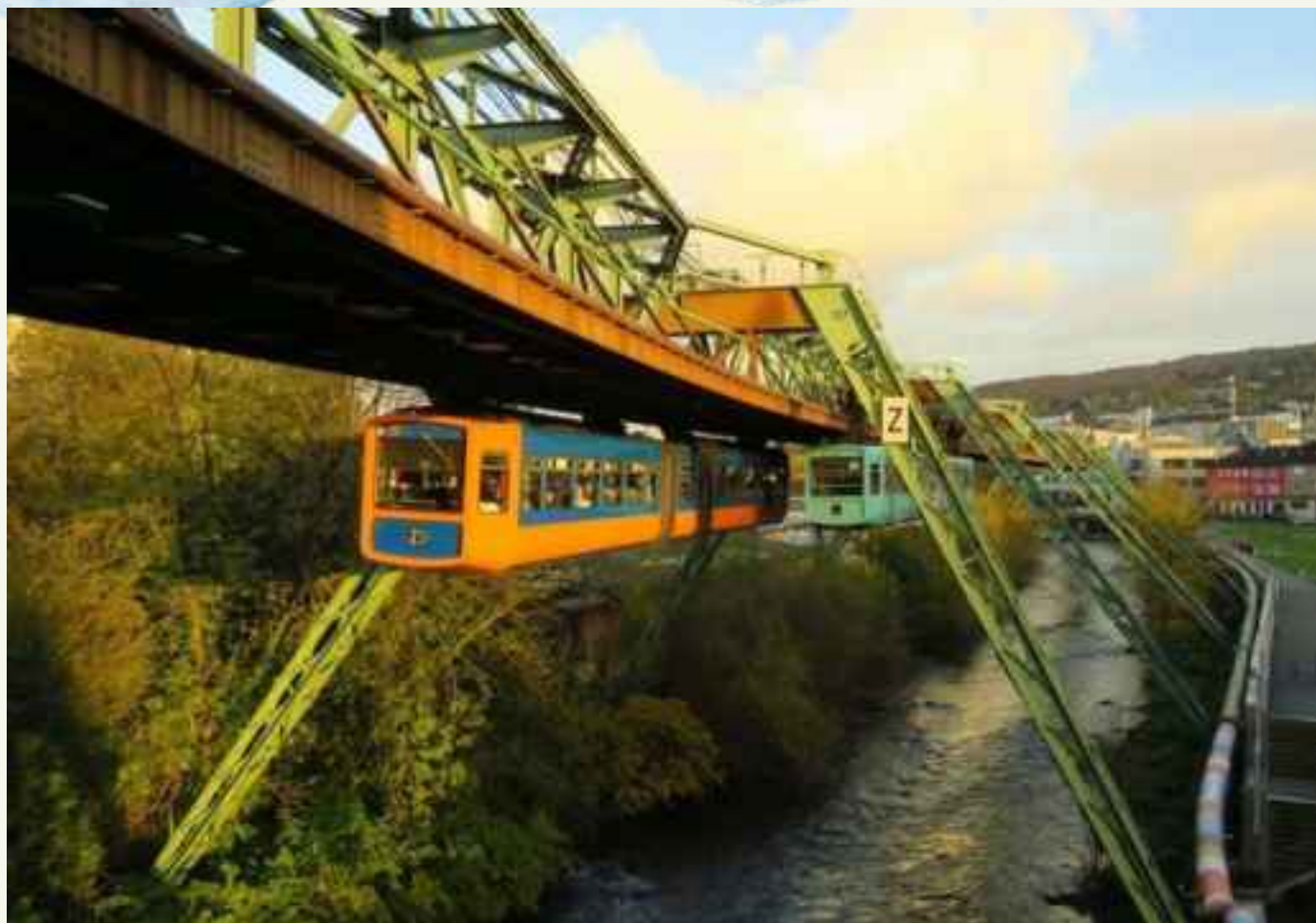
Підвісна залізниця (Schwebebahn)
